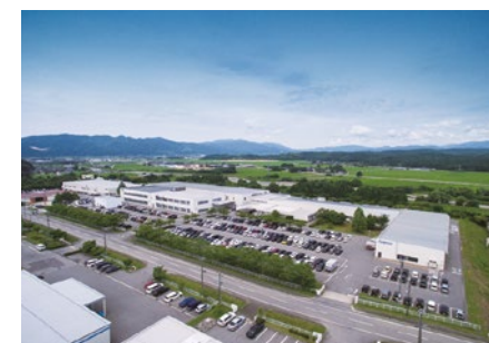
株式会社ジャムコエアクラフトインテリアズ 本社・新潟工場
