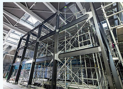
当社製CFRPを用いた防振遮音構造フレーム 写真提供：大成建設株式会社
