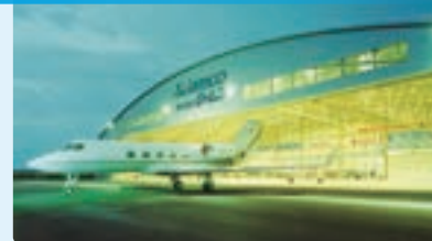
機体整備工場 第二格納庫
